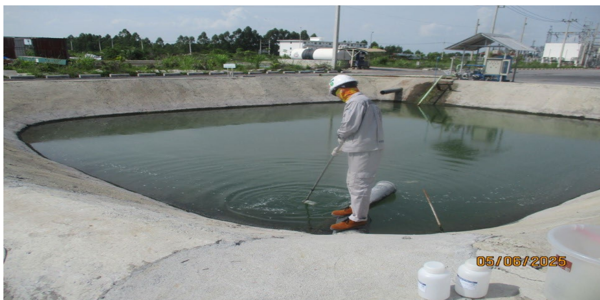
รูปที่ 3.4.4-5 การตรวจวัดคุณภาพน้ำในบ่อตรวจสอบคุณภาพน้ำ
